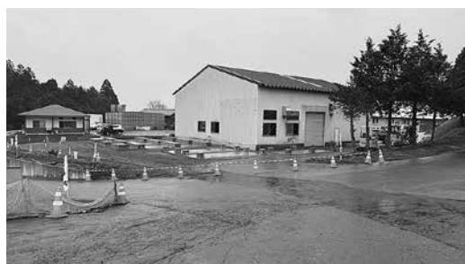
建設中の発電センター
