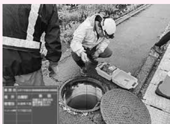
町も調査点検してます
